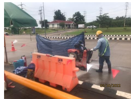
(2) การตัดคอนกรีต
