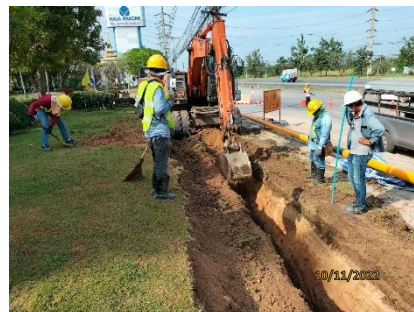
(4) การวางท่อฯ ด้วยวิธีขุดเปิด (Open cut)
