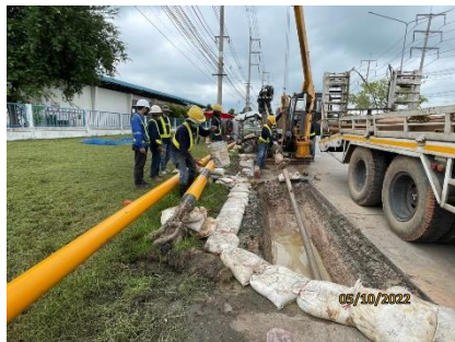
(3) การวางท่อด้วยวิธีเจาะลอด/ตึนลอด (HDD/Boring)
